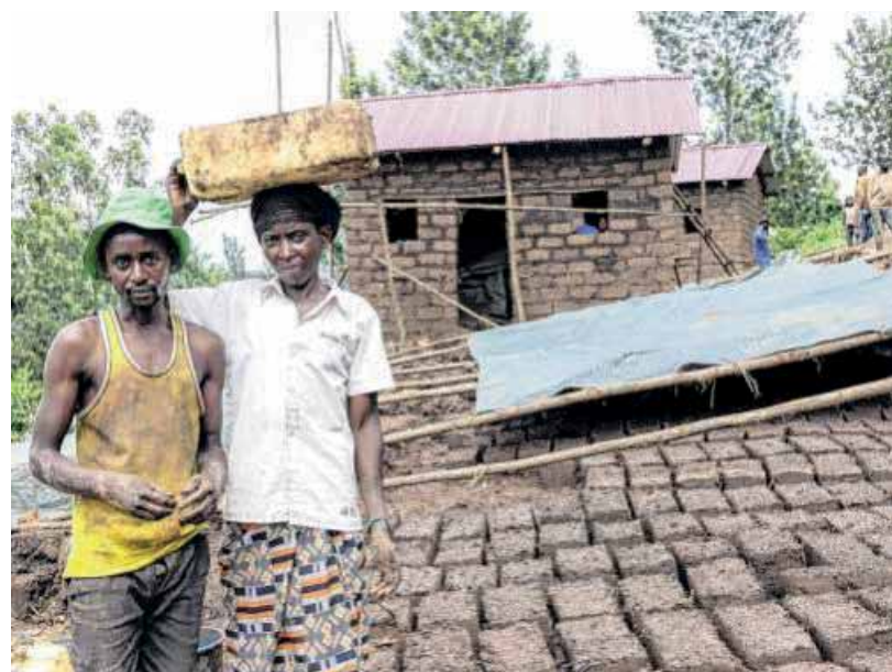
In der Gegend von Gisagara baut dieses Paar ein Haus aus Lehmziegeln, finanziert von großzügigen Allgäuern. Fotos: Ralf Lienert
