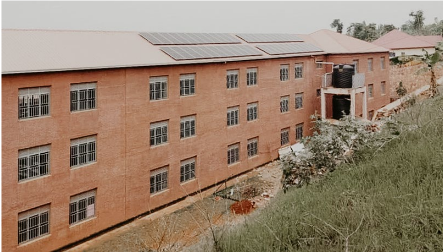
Nachhaltige Energie: Die PV-Anlage schafft Unabhängigkeit und senkt langfristig Kosten
